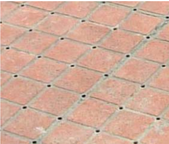
環保透水透氣混凝土鋪面
