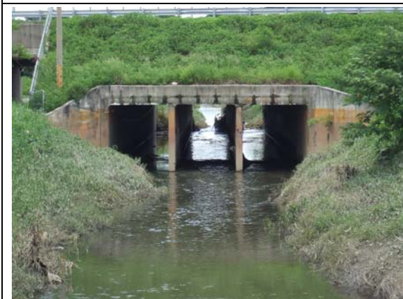
永 17-高速公路三孔箱涵
