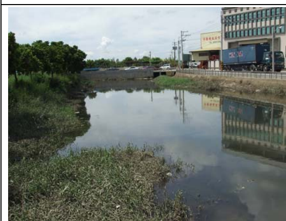
蔦小 3-三老爺宮旁滯洪池
