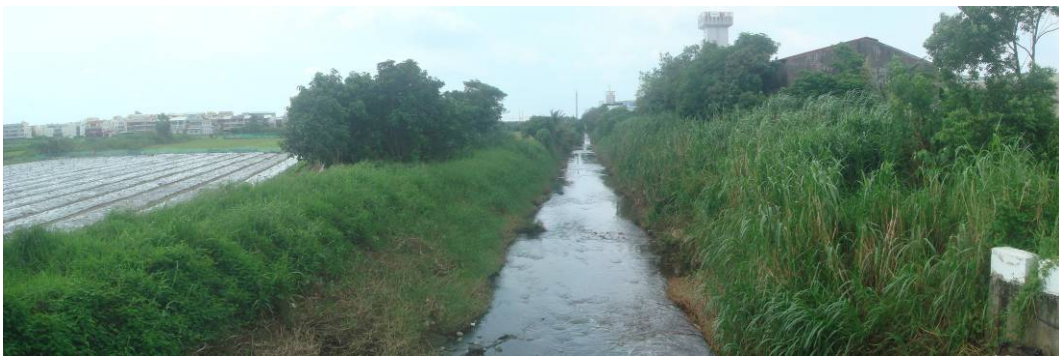
圖 3-36 蜈蚣潭中排之自強橋測站下游棲地環境照(96年9月)
