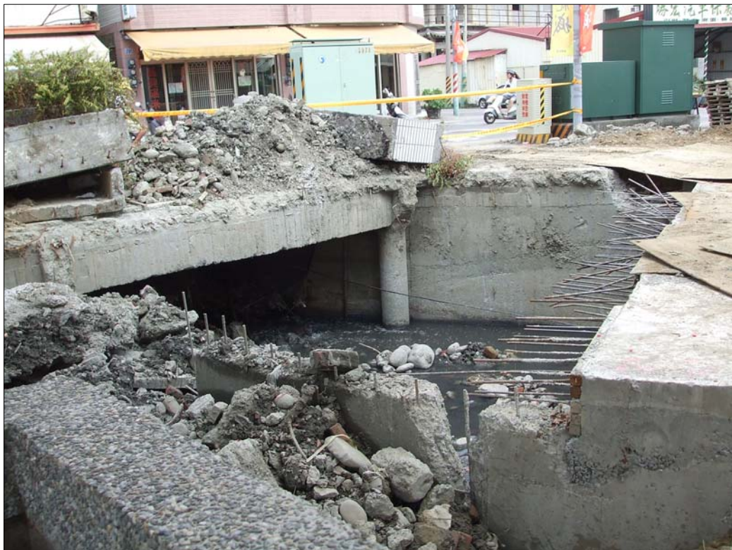
圖 2-17 龍潭里蜈蚣潭中排整治工程施工作現況
