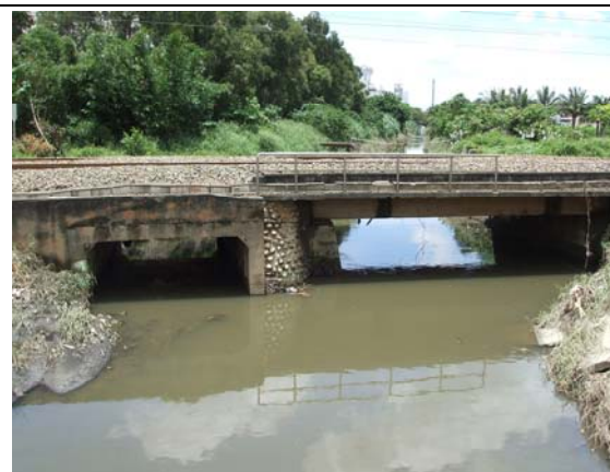
蜈 4-縱貫鐵路橋
