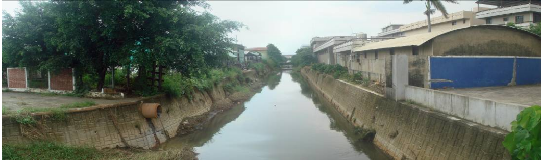
圖 3-33 蜈蚣潭中排之竹子橋測站下游棲地環境照(96年9月)
