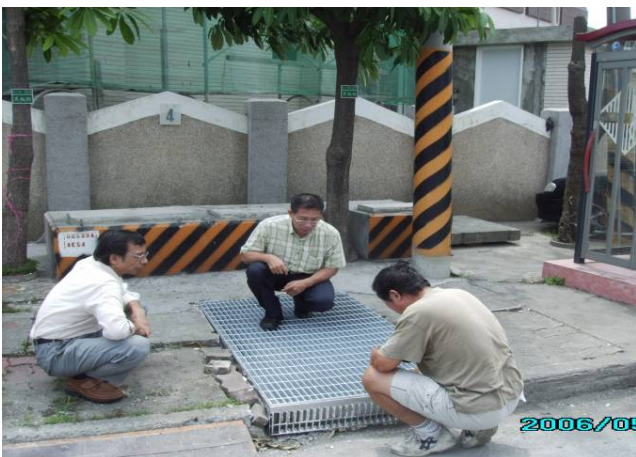
圖 3-10 雨水隔柵蓋施作情形 (永康工業區提供)
