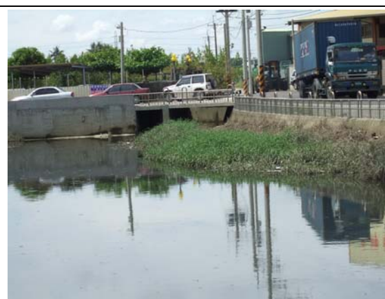
蔦小 4-三老爺宮旁滯洪池 2
