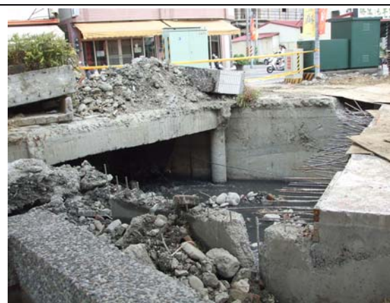
蜈 16-龍潭里活動中心旁箱涵改善施工
