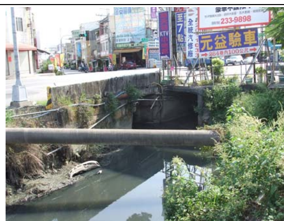
蜈 14-蜈東橋下游管涵橫越
