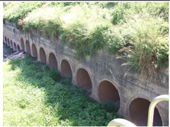
永 4-永康大排排入鹽水溪之排水涵洞
