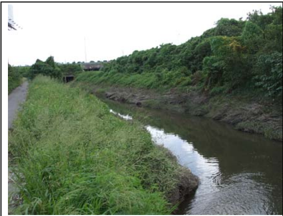
永 19-蔦松中排匯入永康大排處
