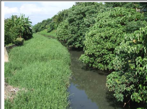
永 9-仁愛橋上游右岸嚴重淤積
