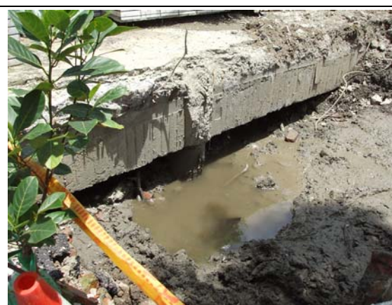
蜈 12-蜈南橋附近工地施工阻礙水流
