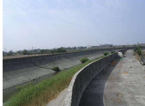
照片 2：後鎮排水路中游段之堤防已完竣，雖可將高地洪水約束在渠道內，但增加竹園後及新厝等村落內水之排水困難。
