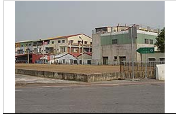
照片 18：侯伯村活動中心槌球場興建於後壁排水路上方，下方箱涵墩柱造成通水障礙，洪水易漫淹至路面。
