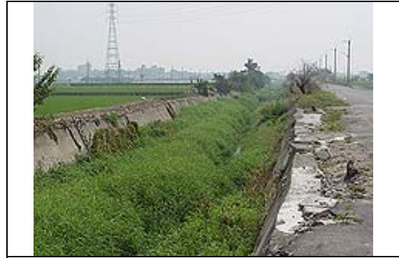
照片 16：菁寮排水上游段兩側築有護岸，惟排水路土砂淤積嚴重，雜草叢生，阻礙水流。
