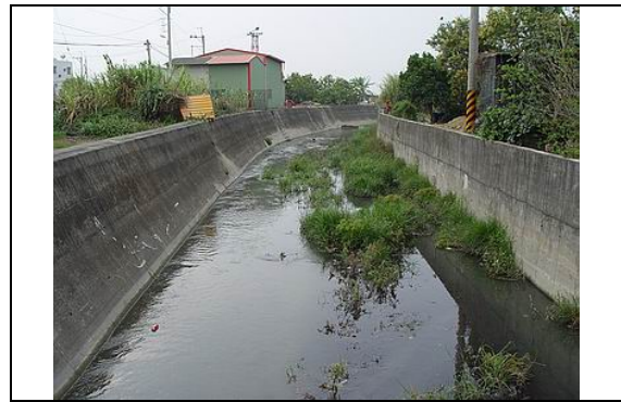
照片 20：菁寮排水支流長短樹排水水路狀況良好，但有輕微淤積產生。
