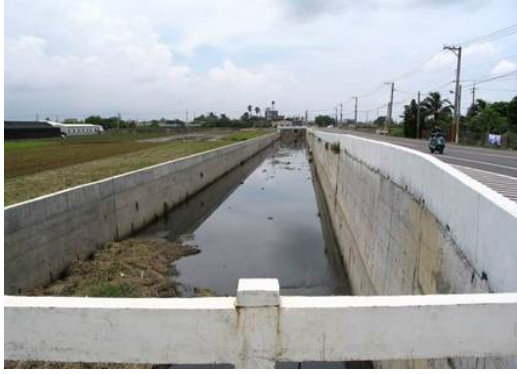
既有混凝土護岸
