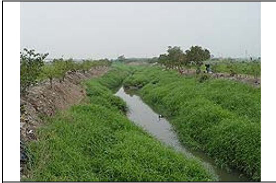
照片 15：魚寮橋附近排水路，汛期洪水位常高過兩岸土堤造成溢堤漫淹。
