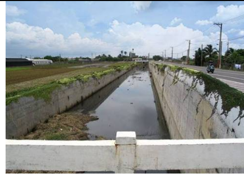
圖9-2-21 既設擋土牆護岸加高及加設植栽槽型式(TypeV)護岸示意圖
