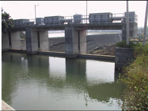
照片 7：下茄苳排水灌溉閘門，抬高水位以利灌溉，惟如操作不及易造成上游村落淹水。
