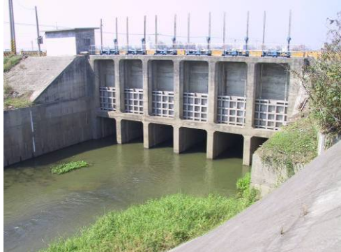
照片 1：八掌溪白沙屯堤防後鎮排水閘門已施設完成，可避免八掌溪倒灌入後鎮排水幹線。
