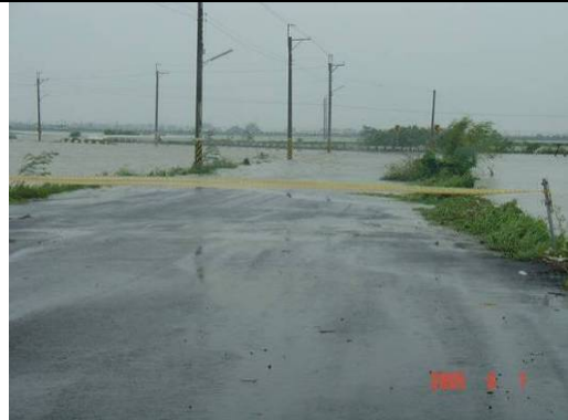
照片 32：豪雨期間，各村落間聯絡道路遭洪水淹沒，延誤救災時效。
