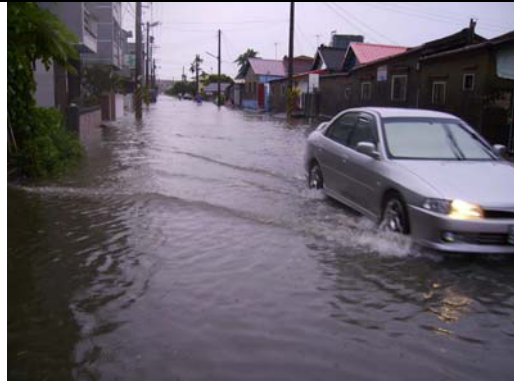
照片 34：聖帕颱風安溪寮社區內道路積水高度約 20 公分。
