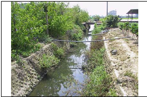
照片 19：菁寮排水支流蘆竹潭排水於新嘉村內均已加蓋，下游匯流至菁寮排水幹線前為漿砌石護岸，寬度約 2.5 公尺。
