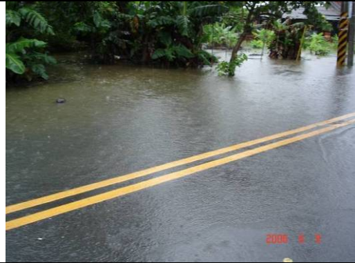
照片 30：菁寮排水洪水溢流，沿南 84 線進崁頂村。
