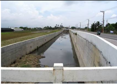
圖9-2-21 既設擋土牆護岸加高及加設植栽槽型式(TypeV)護岸示意圖
