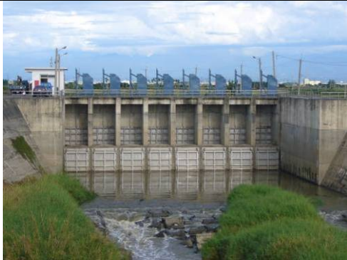
照片 11：菁寮排水幹線之排水閘門完成後，已能有效防止八掌溪之溪水入侵。
