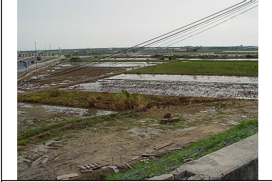
照片 21：計畫區內排水路坡降平緩不易將水排出，照片為 96 年 8 月 13 日豪雨後前往勘查狀況，農田內仍有積水，需較長時間排除內水。
