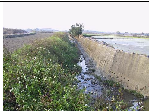
照片 10：下茄苳排水上游段至本協處皆有混凝土護岸，目前狀況良好。
