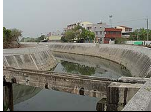
照片 6：下茄苳排水路，兩側護岸已加高，有助高地排水，但也造成內水不易排放。
