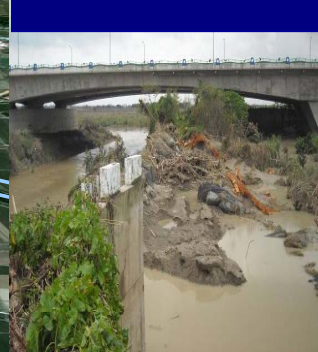
右岸土堤沖毀已修復(懸臂式擋土牆+土籠)
