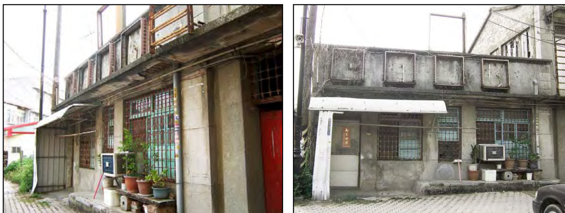
圖 5-31 黑貓酒家拆除前照片
