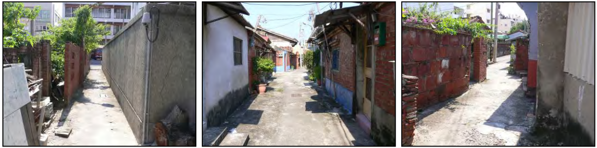
圖 5-22 一銀巷現況照片
