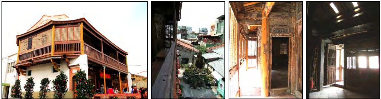
圖 5-27 八角樓現況照片
