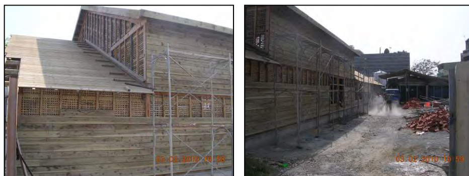
圖 5-30 永成戲院整修現況照片
