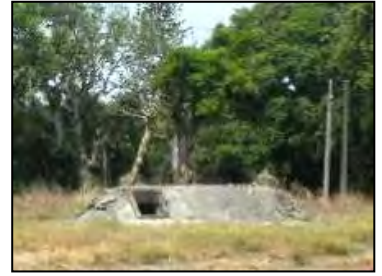
圖 5-50 岸內糖廠防空洞現況照片
