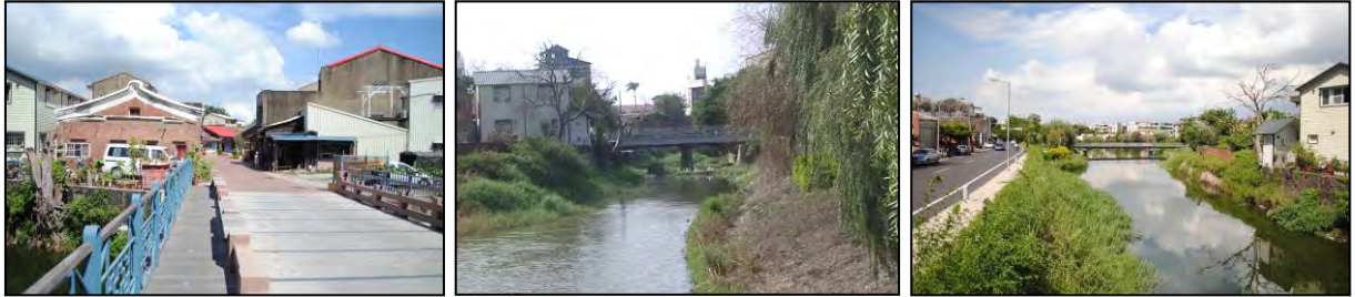
圖 5-25 興隆橋及其周邊環境現況照片
