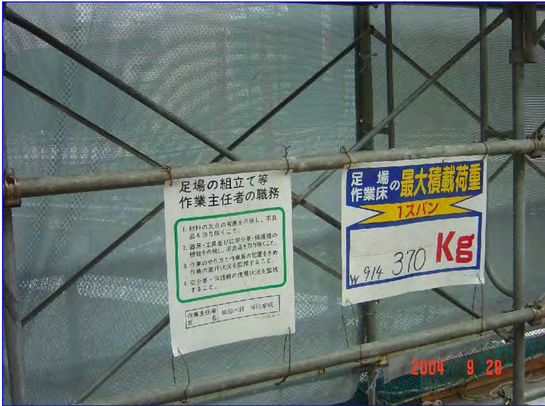
照片 8：施工架上之載重限制應於明顯易見之處明確標示。
