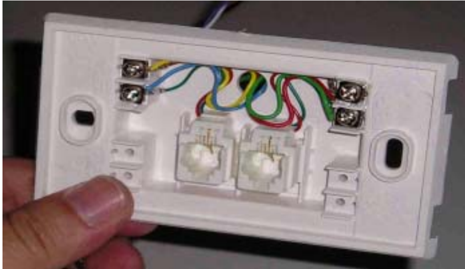
圖 9-8 將心線鎖緊
