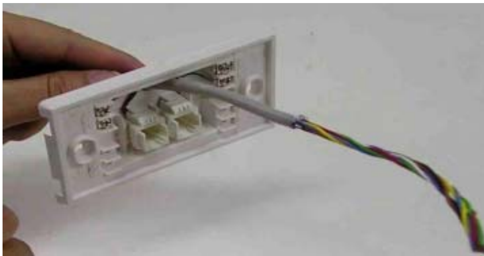
圖 9-6 剝除電纜外被
