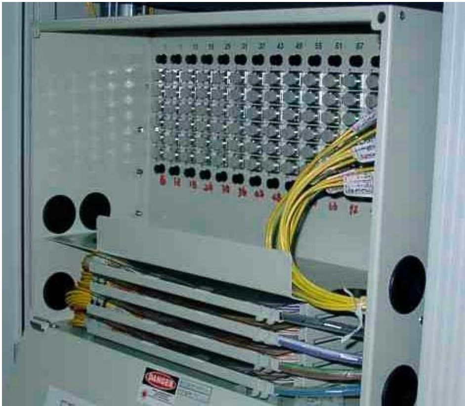
圖 13-4 用戶光纜配線箱圖例二
