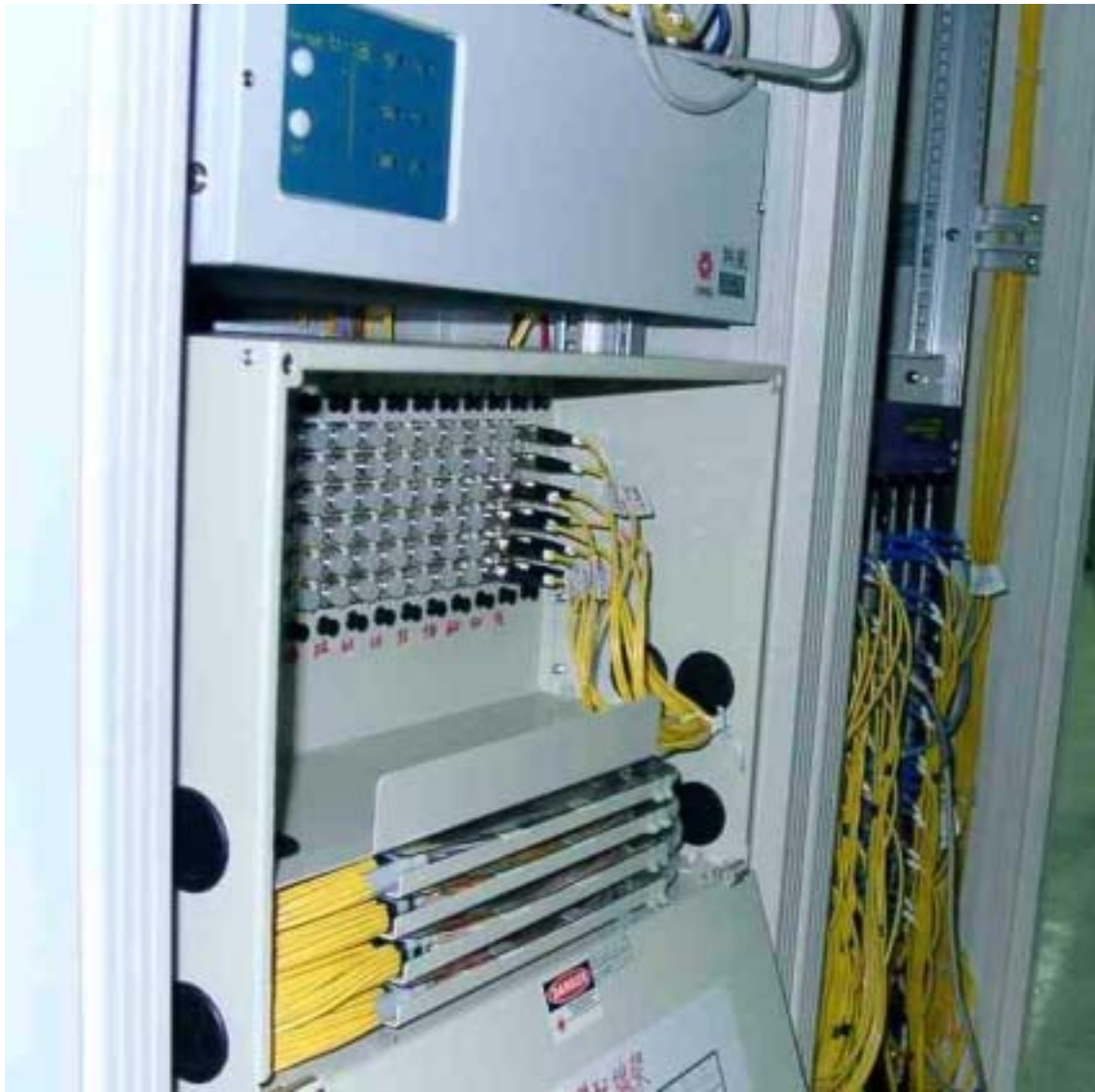
圖 13-3 用戶光纜配線箱圖例一
