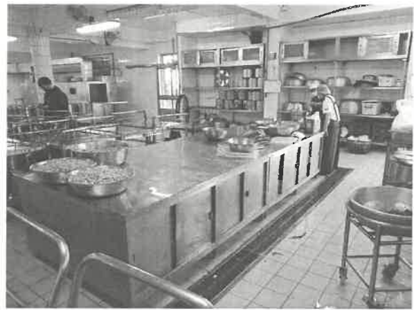
廚房不鏽鋼料理檯面及該區之廚房排水溝
