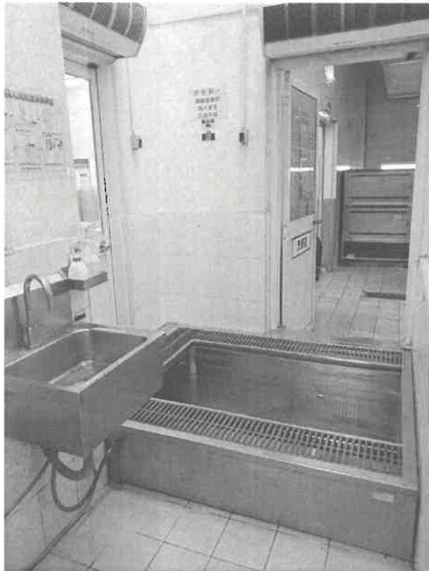
進入廚房烹飪區前必經之消毒水泡鞋池
