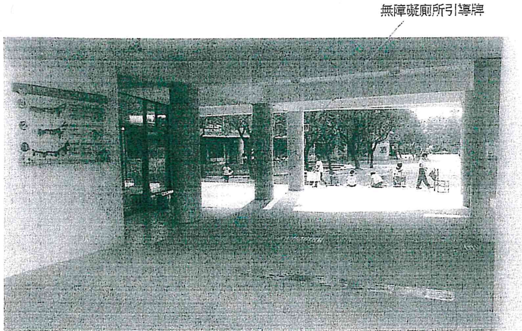
照片 6 - 無障礙廁所及引導位置照片
