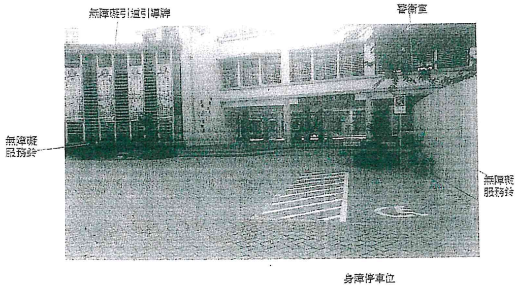
照片 2 - 無障礙車位、無障礙通路、無障礙服務鈴位置照片
