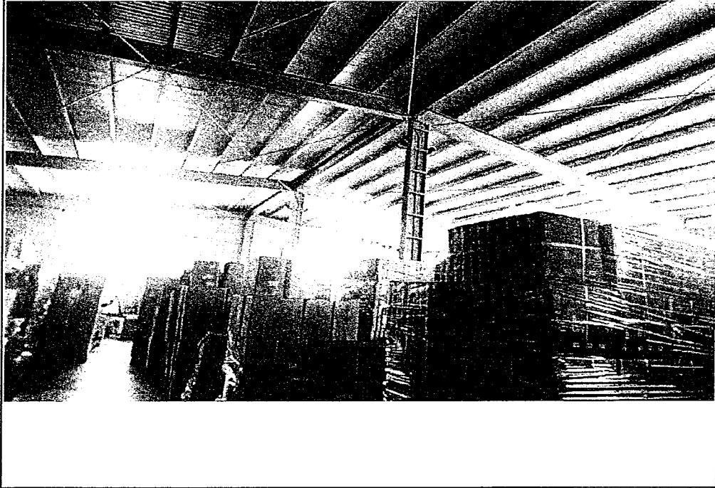
屋頂增建儲藏室現況照片
