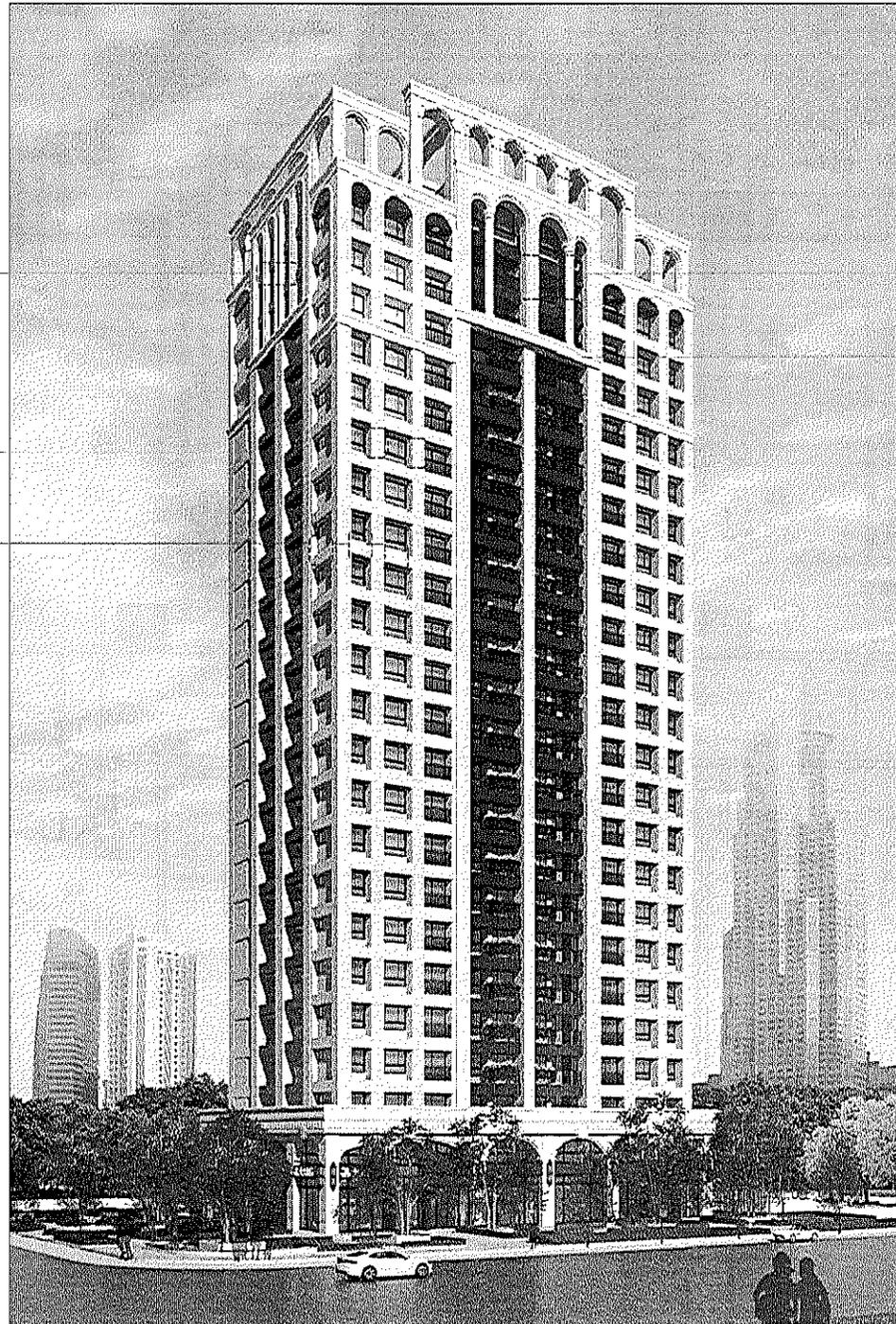
本案建築外觀採古典造型元素並利用樑柱所產生之框架營造量體厚實質感。於建築外觀雨遮上方及部分外牆及高樓層結構性過樑上設計裝飾造型牆，塑造建築物古典意象(如圖示)，並無礙通風、採光等功能。建物裝飾造型語彙之設計，是否適用建築物外牆設置之裝飾板或裝飾物，不得超過位於結構柱、樑外緣，外牆之最外緣者六十公分設計之基準？
