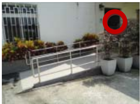
坡道扶手端部防勾撞處理
