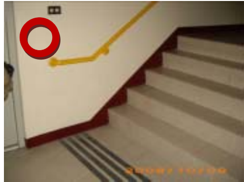
樓梯扶手端部固定於牆上防勾撞
