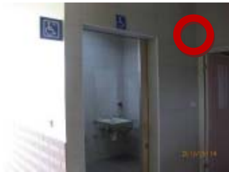
無障礙標誌標示無障礙廁所案例
