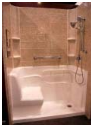
移位式淋浴間案例，空間尺寸及水平扶手符合，但缺少垂直扶手。
