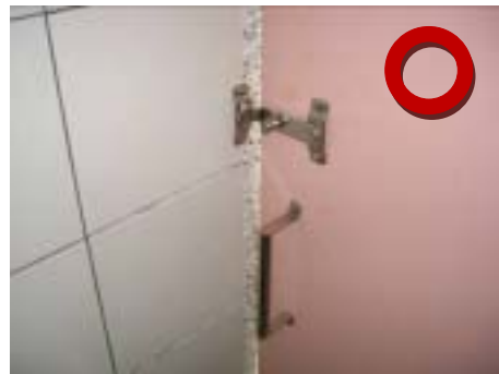
廁所盥洗室之門鎖，為便利手部肢障者使用，建議使用撥桿式門鎖。
