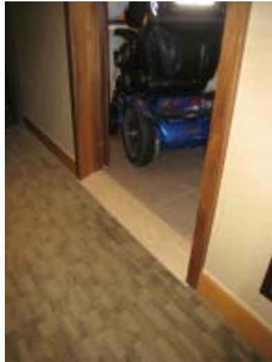
門口作斜面處理方便輪椅進出
