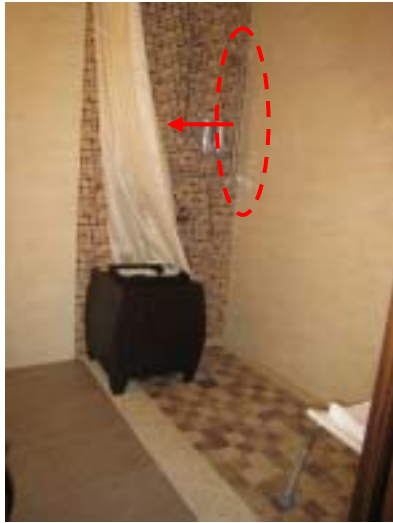
淋浴區設置洗澡椅，但垂直扶手應靠外側並降低。
