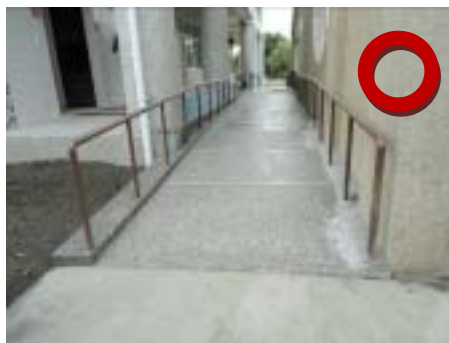
坡道扶手端部防勾撞處理
