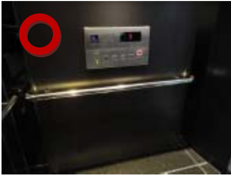
輪椅乘坐操作盤設置位置正確案例
