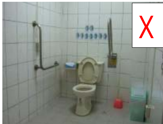
扶手距馬桶中心的距離左右不對稱，高低也不相同。
