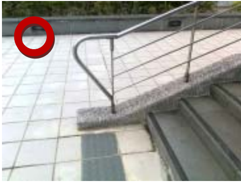
樓梯扶手端部防勾撞處理
