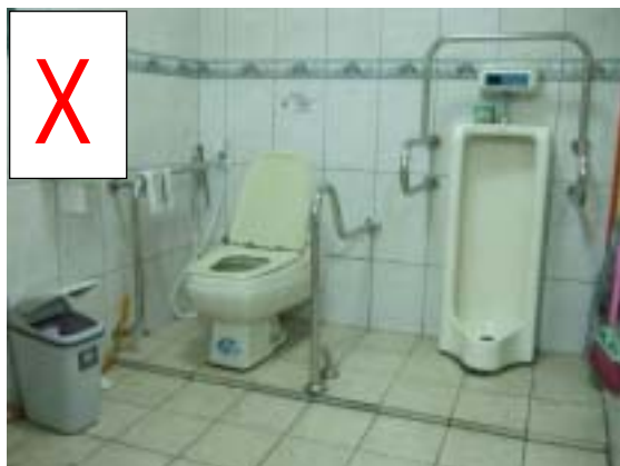
錯誤的扶手型式設置及方式
